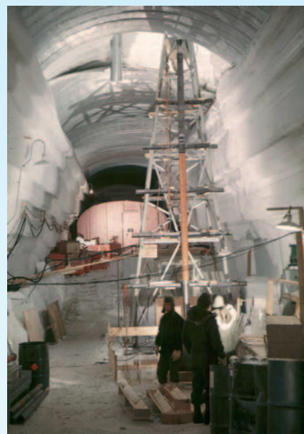
Iskerneboredstyret monteret i en ishule i Camp Century-lejren.
